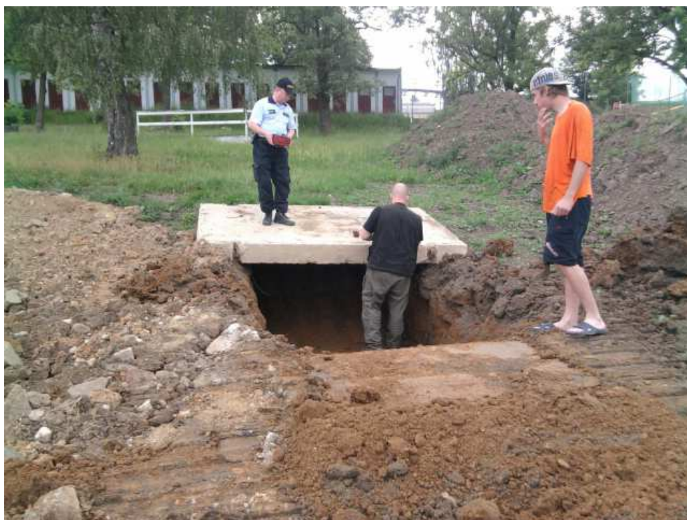
Obr. 21 Pohled na trhací jámu zřízenou přímo na staveništi
